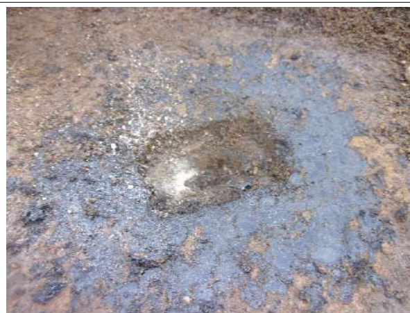
Prélèvement - P006 : BAT 23 - BARIETY / EXTERIEUR / TOITURE TERRASSE ETAGE 2 - Ragréage- (Absence d'amiante)
