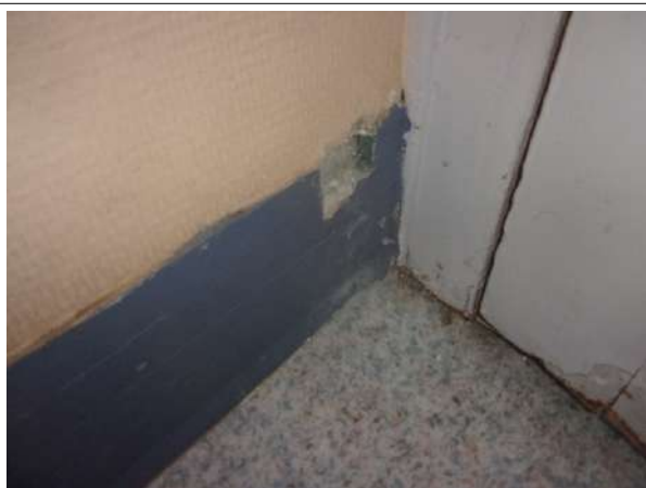
Prélèvement - P015 : BAT 23 - BARIETY / R+2 / PIECE / 3026 - Colle de plinthe- (Absence d'amiante)
