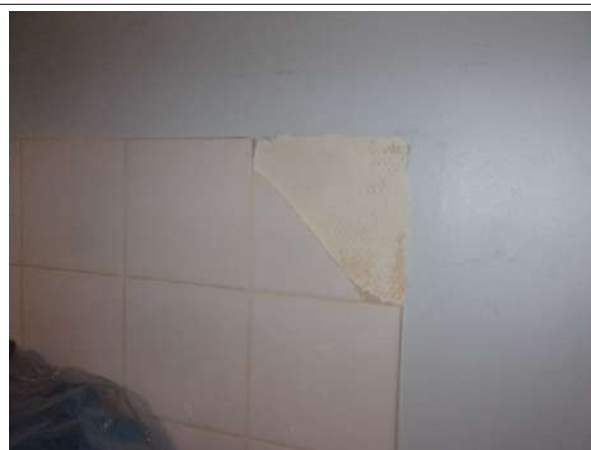
Prélèvement - P047 : BAT 23 - BARIETY / SOUS SOL / PIECE 0030 - Colle de faïence- (Absence d'amiante)
