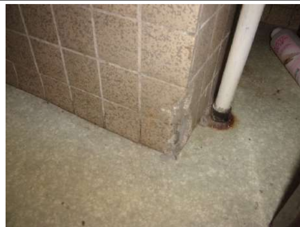
Prélèvement - P002 : BAT 23 - BARIETY / R+2 / PIECE / 3031 - Colle de faïence- (Absence d'amiante)
