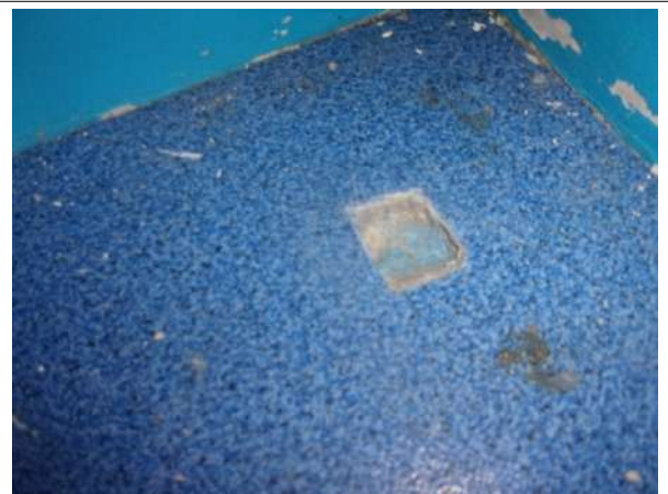
Prélèvement - P010 : BAT 23 - BARIETY / RDC / PIECE 1039 - Lé plastique- (Absence d'amiante)
