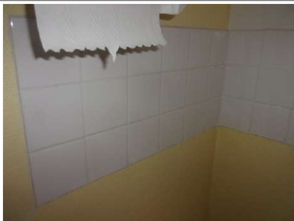
Prélèvement - P007 : BAT 23 - BARIETY / R+2 / PIECE / 3006 - Colle de faïence- (Absence d'amiante)
