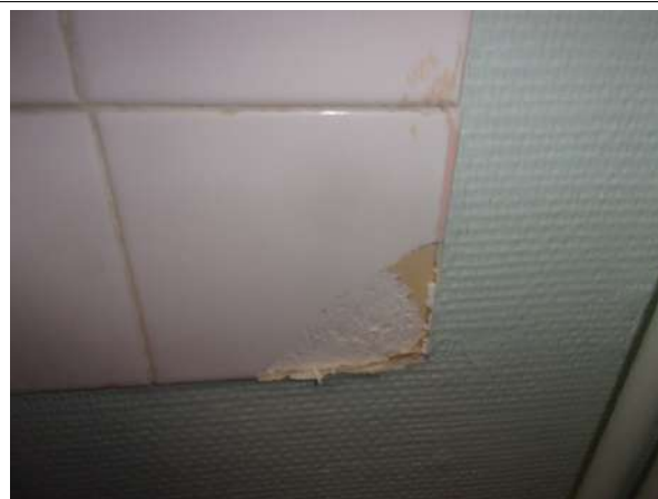
Prélèvement - P004 : BAT 23 - BARIETY / SOUS SOL / PIECE 0013 - Colle de faïence- (Absence d'amiante)
