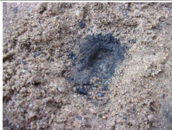
Prélèvement - P012 : BAT 23 - BARIETY / EXTERIEUR / TOITURE TERRASSE ETAGE 1 - Revêtement bitumineux- (Absence d'amiante)
