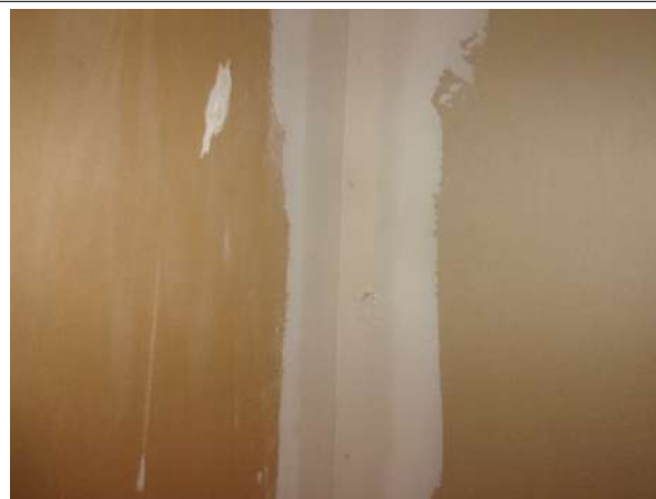
Prélèvement - P008 : BAT 23 BARIETY / R+3 / PIECE / 4012 - Bande de plaque de plâtre- (Absence d'amiante)
