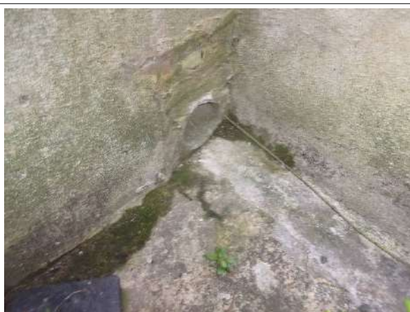
Prélèvement - P028 : BAT 23 - BARIETY / SOUS SOL / EXTERIEUR - Conduit- (Présence d'amiante)
