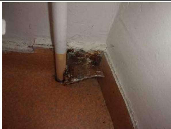
Prélèvement - P019 : BAT 23 - BARIETY / R+1 / PIECE / 2023 - Colle de plinthe- (Présence d'amiante)
