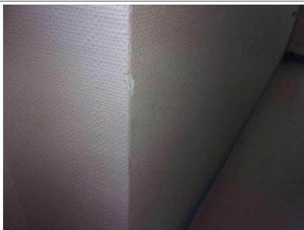
Prélèvement - P012 : BAT 23 - BARIETY / RDC / PIECE 1024 - Toile de verre- (Absence d'amiante)
