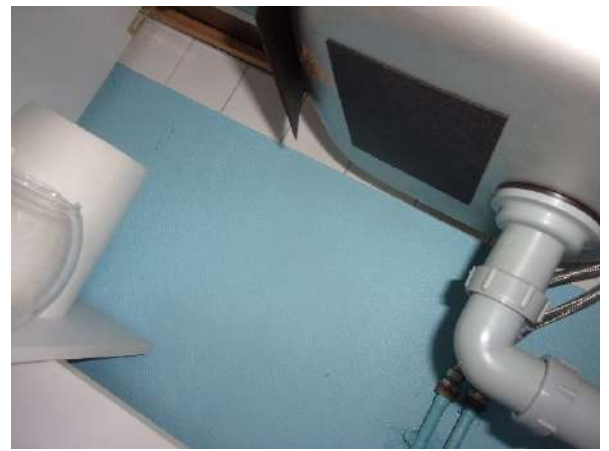
Prélèvement - P008 : BAT 23 - BARIETY / R+1 / PIECE / 2017 - Plaque bitumineuse- (Absence d'amiante)
