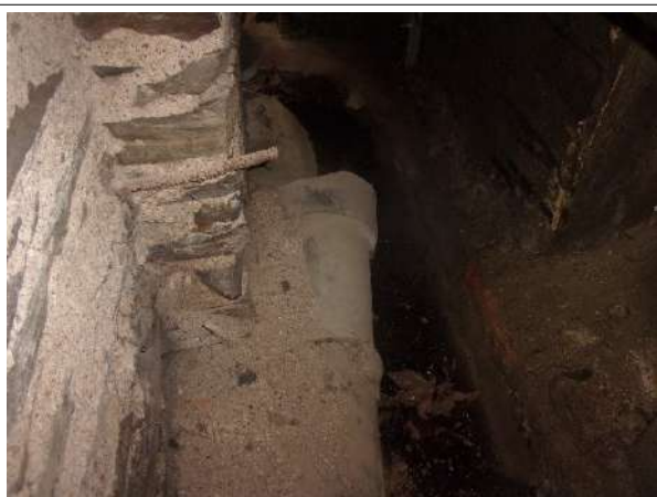
Prélèvement - P028 : BAT 23 - BARIETY / SOUS SOL / EXTERIEUR - Conduit- (Présence d'amiante)
