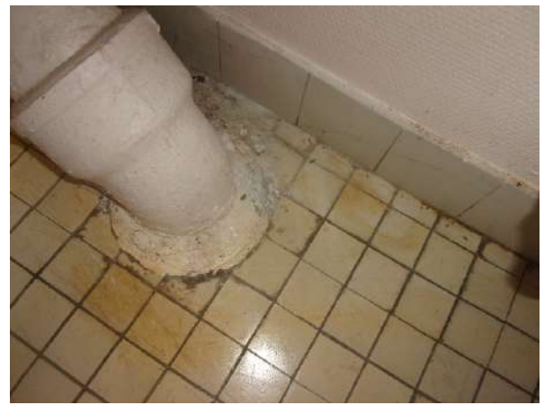
Prélèvement - P036 : BAT 23 - BARIETY / SOUS SOL / PIECE 0022 - Colle de plinthe- (Absence d'amiante)
