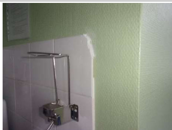
Prélèvement - P010 : BAT 23 - BARIETY / R+2 / PIECE / 3001 - Colle de faïence- (Absence d'amiante)
