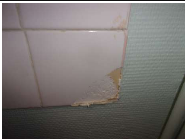
Prélèvement - P003 : BAT 23 - BARIETY / SOUS SOL / PIECE 0013 - Colle de faïence- (Absence d'amiante)
