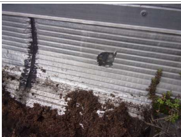
Prélèvement - P013 : BAT 23 - BARIETY / EXTERIEUR / TOITURE TERRASSE ETAGE 1 - Relevé d'étanchéité- (Absence d'amiante)
