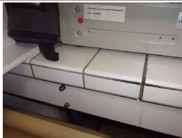
Prélèvement - P043 : BAT 23 - BARIETY / SOUS SOL / PIECE 0029 - Colle de faïence- (Absence d'amiante)
