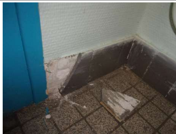
Prélèvement - P002 : BAT 23 - BARIETY / SOUS SOL / PIECE 0013 - Colle de plinthe- (Présence d'amiante)
