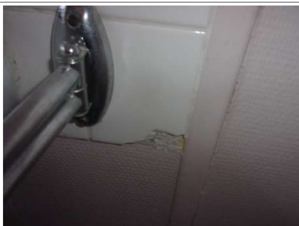
Prélèvement - P017 : BAT 23 - BARIETY / R+2 / PIECE / 3025 - Colle de faïence- (Absence d'amiante)
