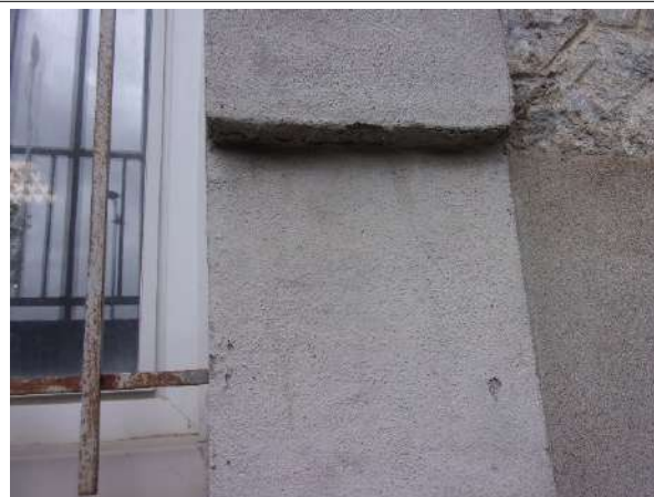
Prélèvement - P030 : BAT 23 - BARIETY / SOUS SOL / EXTERIEUR - Enduit- (Absence d'amiante)
