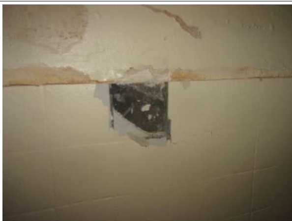
Prélèvement - P040 : BAT 23 - BARIETY / SOUS SOL / PIECE 0023 - Colle de faïence- (Absence d'amiante)
