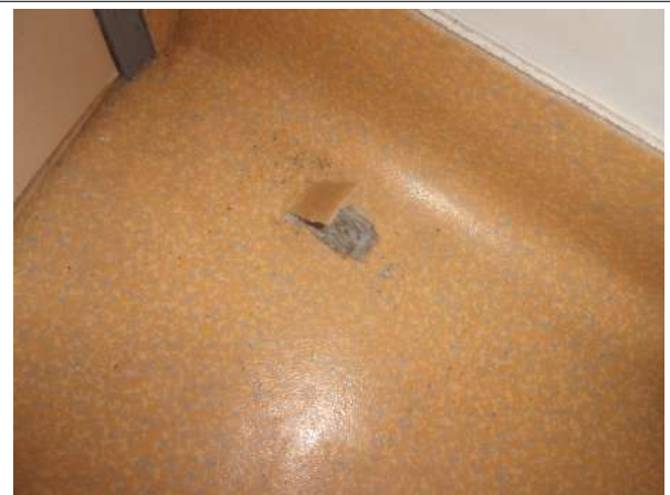
Prélèvement - P016 : BAT 23 - BARIETY / R+1 / PIECE / 2029 - Lé plastique- (Absence d'amiante)
