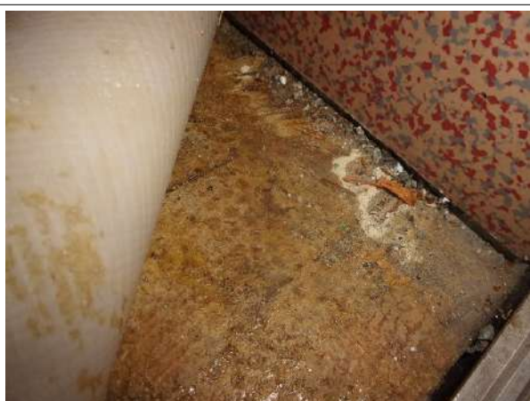
Prélèvement - P21 : BAT 23 BARIETY / R+4 / ASCENSEUR / CABINE - Colle- (Présence d'amiante)
