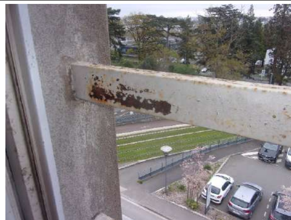
Prélèvement - P002 : BAT 23 BARIETY / R+3 / PIECE / 4002 - Peinture- (Absence d'amiante)
