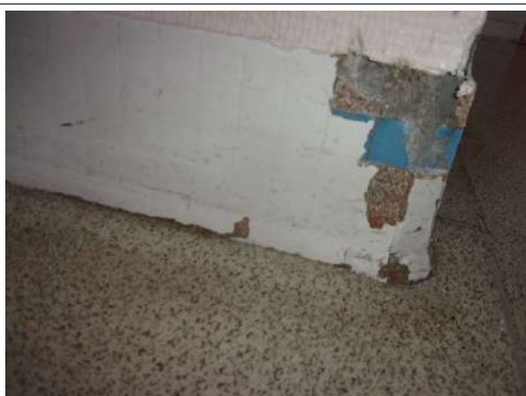
Prélèvement - P005 : BAT 23 - BARIETY / R+2 / PIECE / 3031 - Colle de plinthe- (Absence d'amiante)
