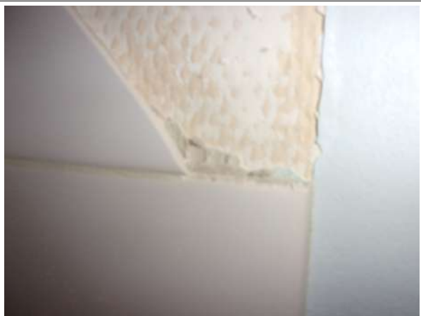
Prélèvement - P048 : BAT 23 - BARIETY / SOUS SOL / PIECE 0030 - Colle de faïence- (Absence d'amiante)
