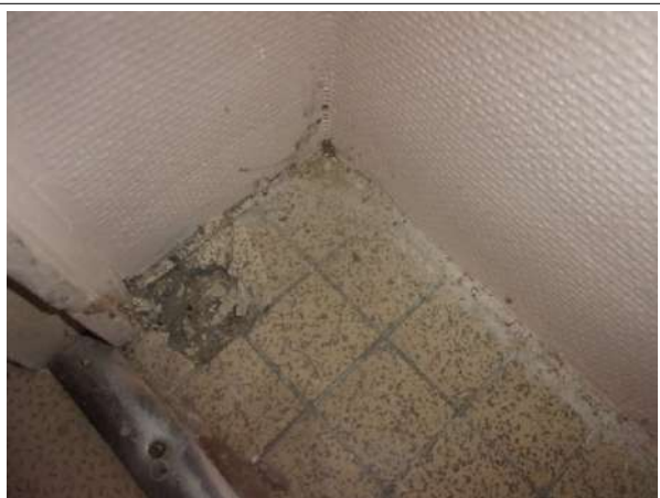
Prélèvement - P019 : BAT 23 - BARIETY / R+2 / PIECE / 3036 - Colle de carrelage- (Absence d'amiante)
