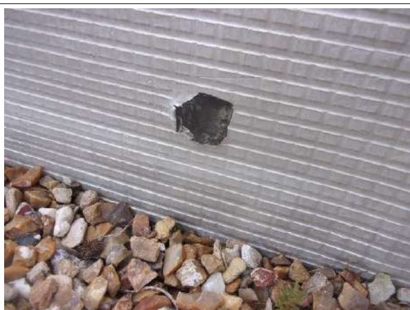
Prélèvement - P003 : BAT 23 - BARIETY / EXTERIEUR / TOITURE TERRASSE CHAUFFERIE - Relevé d'étanchéité- (Absence d'amiante)
