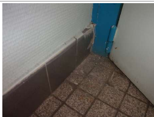
Prélèvement - P006 : BAT 23 - BARIETY / SOUS SOL / PIECE 0007 - Colle de plinthe- (Présence d'amiante)
