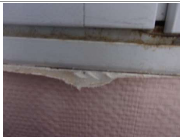
Prélèvement - P021 : BAT 23 - BARIETY / RDC / PIECE 1033 - Toile de verre- (Absence d'amiante)
