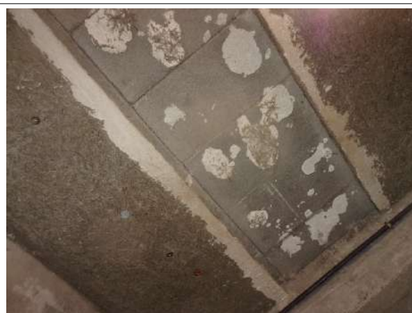
Prélèvement - P016 : BAT 23 - BARIETY / SOUS SOL / PIECE 0031 - Plot de colle- (Absence d'amiante)
