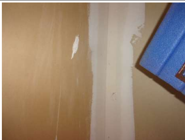
Prélèvement - P007 : BAT 23 BARIETY / R+3 / PIECE / 4012 - Bande de plaque de plâtre- (Absence d'amiante)
