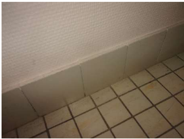
Prélèvement - P035 : BAT 23 - BARIETY / SOUS SOL / PIECE 0022 - Colle de plinthe- (Absence d'amiante)
