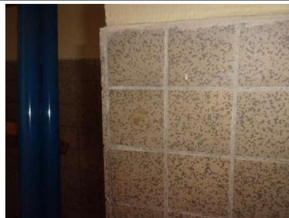
Prélèvement - P002 : BAT 23 - BARIETY / R+1 / PIECE / 2034 - Colle de faïence- (Absence d'amiante)
