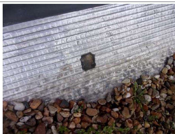
Prélèvement - P010 : BAT 23 - BARIETY / EXTERIEUR / TOITURE TERRASSE ETAGE 2 - Relevé d'étanchéité- (Absence d'amiante)
