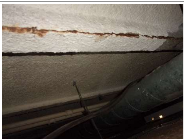
Prélèvement - P050 : BAT 23 - BARIETY / SOUS SOL / PIECE 0030 - Peinture- (Absence d'amiante)
