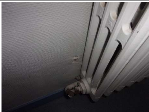
Prélèvement - P013 : BAT 23 - BARIETY / SOUS SOL / PIECE 0009 - Toile de verre- (Absence d'amiante)
